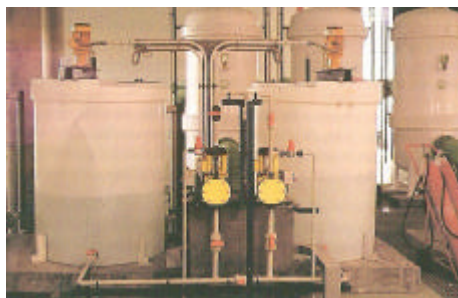
Fig.31. Dosificació de reductor
